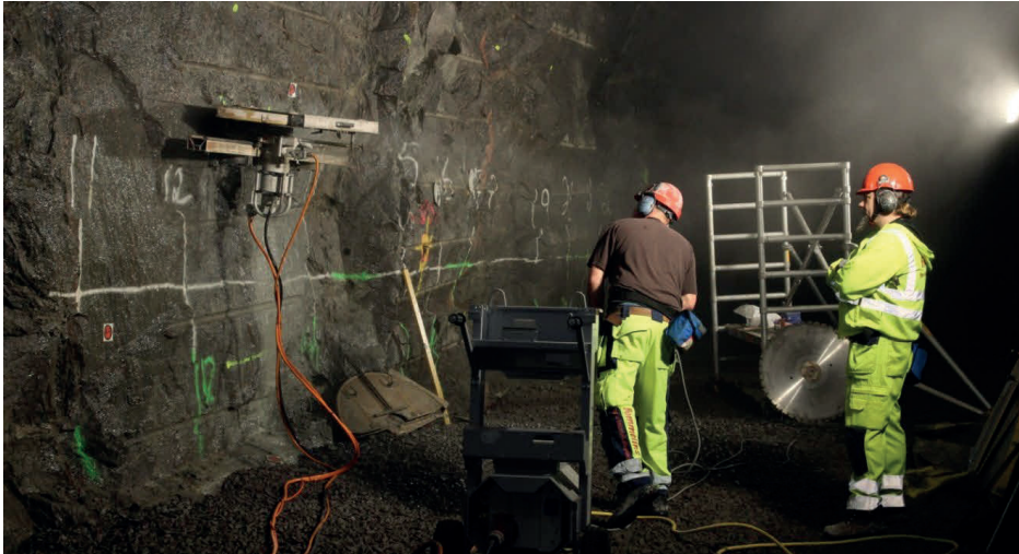
Figur 14. Sågning av slits i väggen, TASN sektion 13 m.
