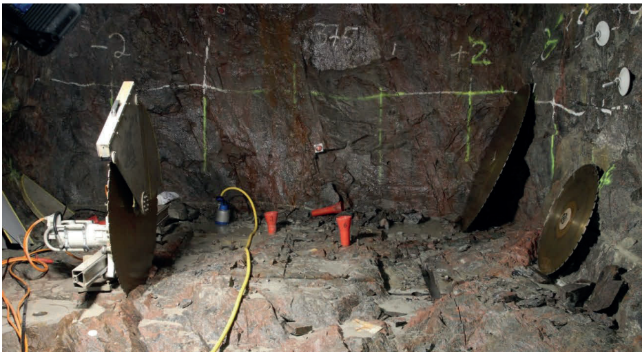
Figur 15. Pågående arbete med uttag av slits i sulan, sektion 34 m i TAS04.
