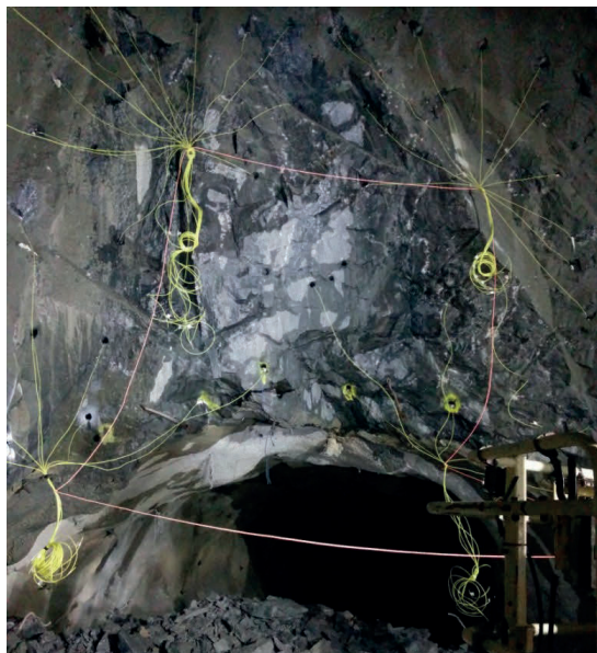
Figur 29. Laddad och kopplad takfällning i Norra rampen inslag 380.
