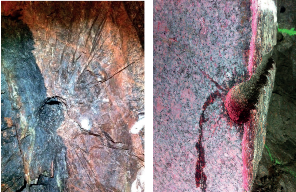
Figur 6. Exempel på sprängsprickor från bottenladdning (till vänster) och kontur (till höger) i TASN, Äspö.
