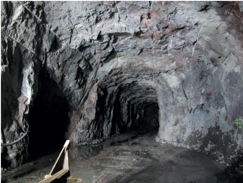
Figur 3. Vändficka i Kistatunneln, sektion ca 0/604 m.
