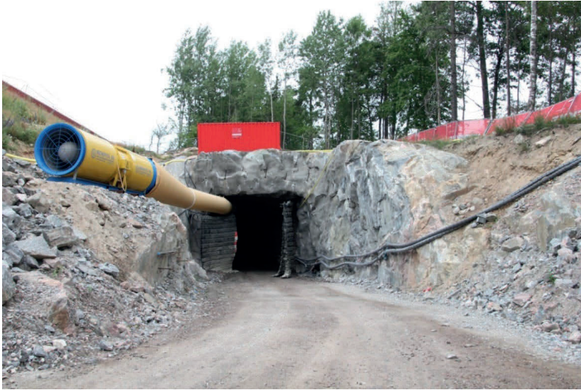
Figur 2. Tunnelpåslag för arbetstunneln i Kista, där fältförsöket genomfördes.
