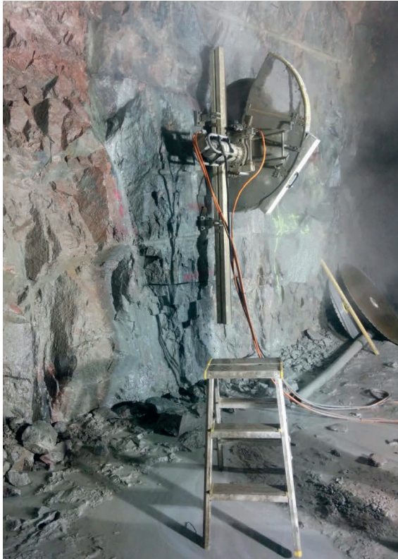
Figur 21. sågning av slits i sektion 0/604 m.
