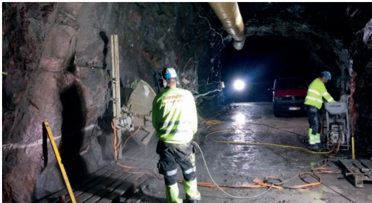
Figur 22. Arbetsplatsen vid sågning av slits i sektion 0/623 m.
