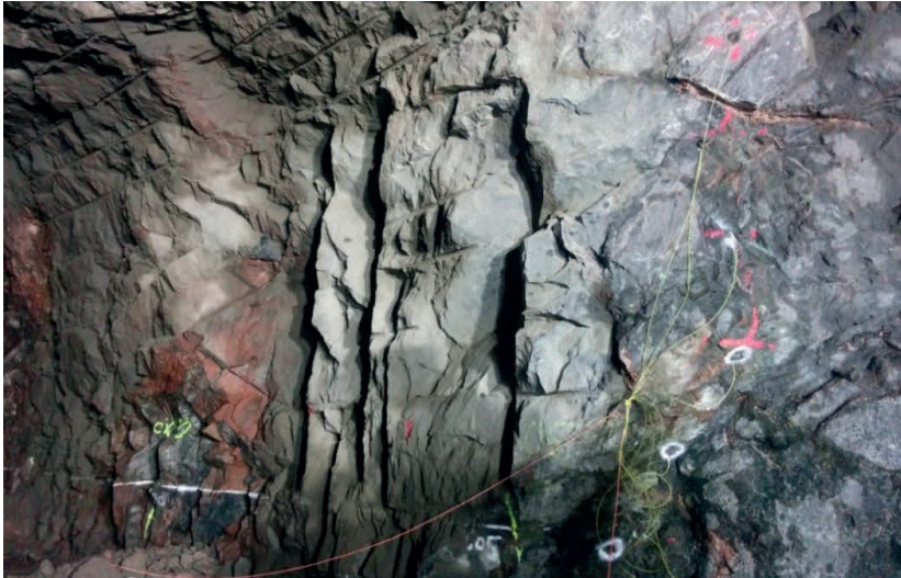
Figur 19. Fem hål (inklusive bottenhålet) laddades med 1,2 kg/m i sektion 0/604 m. Koppling och upptändning av strossen gjordes med Indet shock TS 150 ms.
