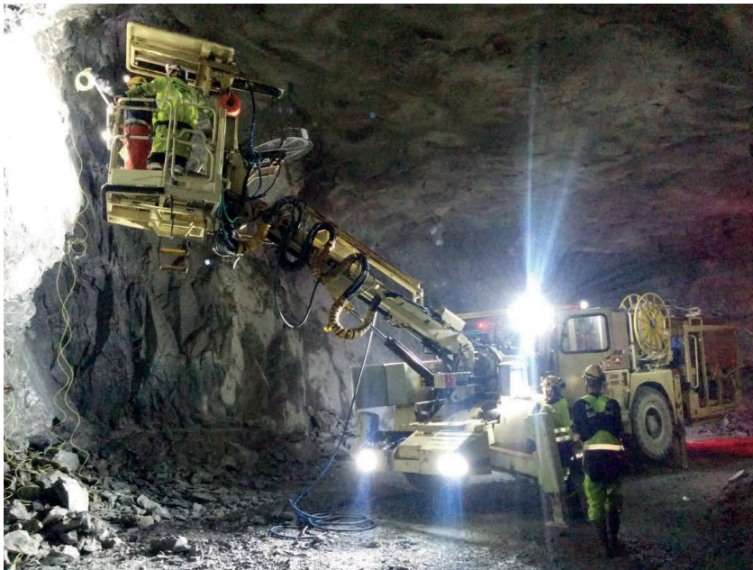
Figur 28. Laddning av takfällning i Kankbergsgruvan.
