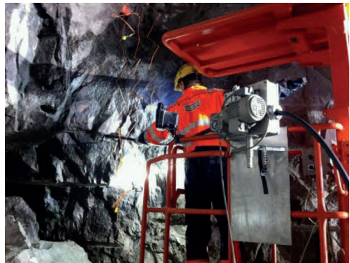
Figur 10. Forcit Laddenhet 201 och laddning med slangdragarenhet i TASJ.
