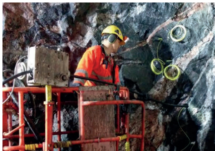
Figur 8. Laddning med slangdragare i Kistatunneln (vänster) och strängladdat konturhål (höger).
