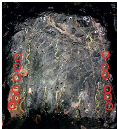
Figur 18. Försöksuppställning vid stuffläge 0/672 m. Rödmarkerade hål laddades med 0,8 kg/m.
