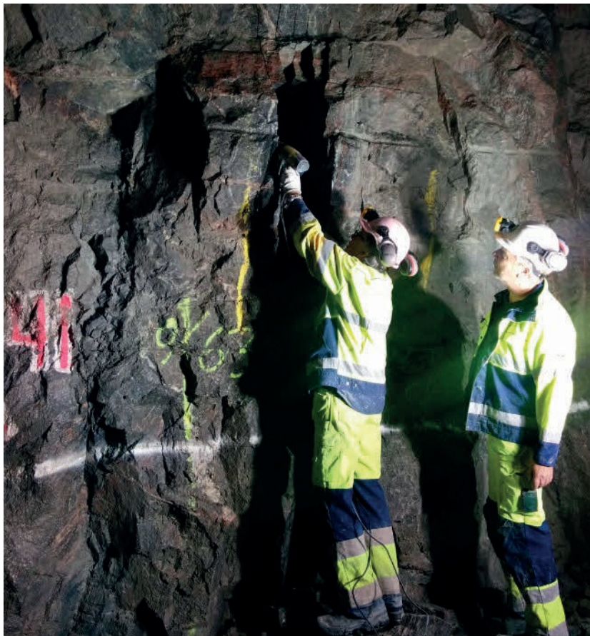
Figur 23. Kartering i Kistatunneln sektion 0/635 m.
