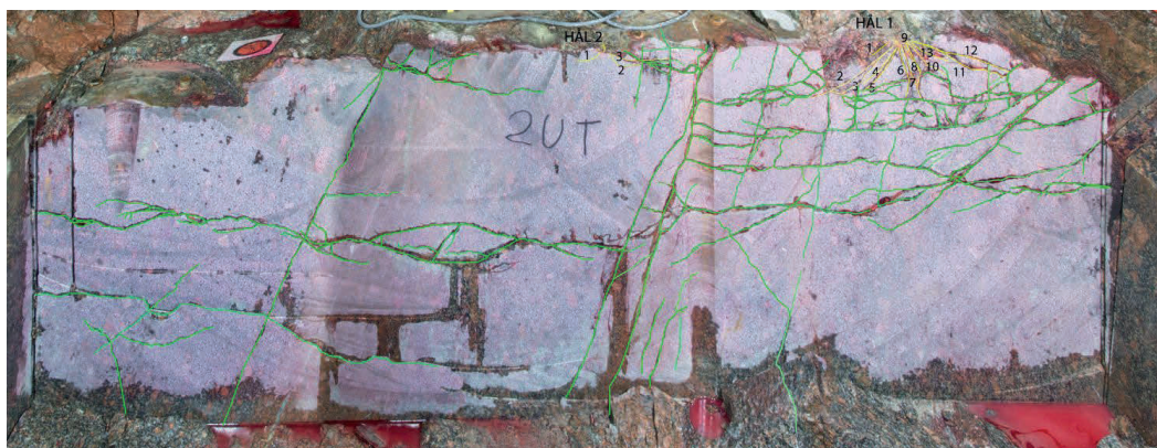
Figur 38. Snittytan TAS04, Sula sektion 34 ut med penetranter samt med inlagda spricktyper.
