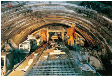
Figur 4: Tunnelproduktion med TBM i den norra delen.
