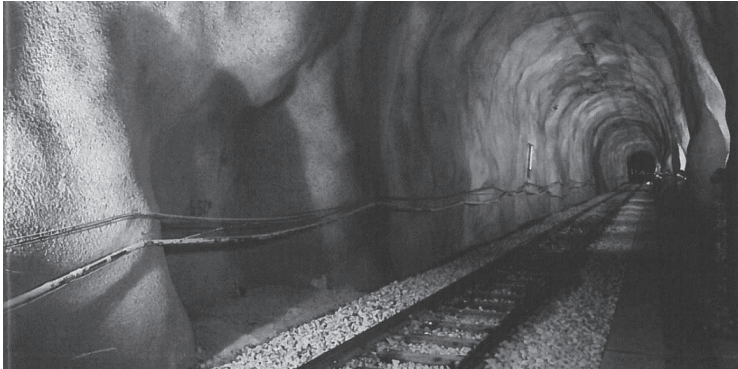
Figur 6: Furkatunnel, bergförstärkning med sprutbetong och GFRP bult.
