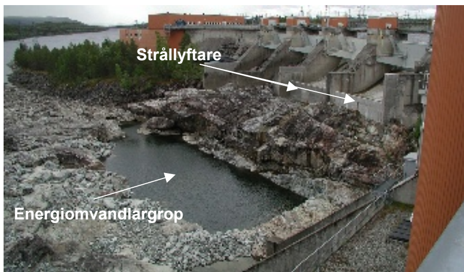
Figur 6 Energiomvandlargrop och strålllyftare i Midskogs utskovskanal. Plunge pool and ski jumps in the Midskog spillway channel.
