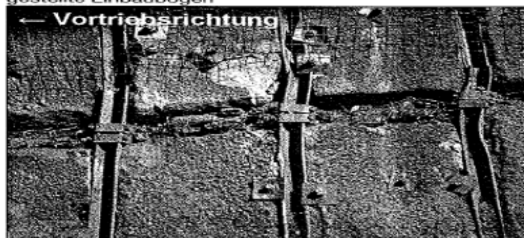
Bild 6: Infolge schiefe Einfallen der Schichtung schief gestellte Einbaubögen
