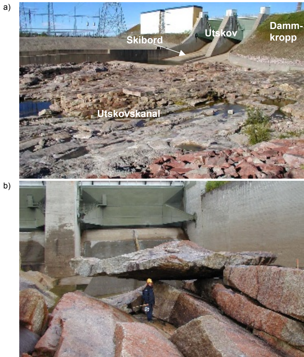
Figur 1 Utskov och bergerosion: a) utskovsdel och damm vid Porjus kraftstation, b) eroderat block nedströms Harsprångets utskov.
